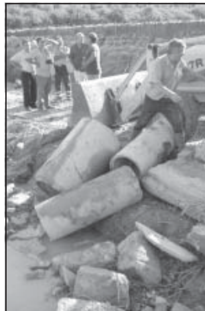
Los daños en infraestructuras, patentes
